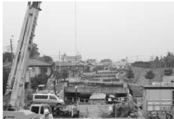
残堀川上流の改修工事
