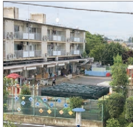
都営住宅1階にあるむさしの保育園
