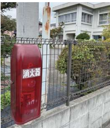
地域配備消火器
