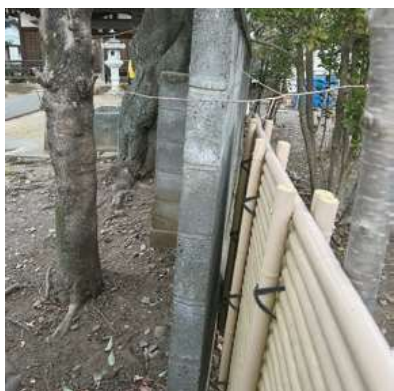
地縁団体が管理している傾斜した堀
