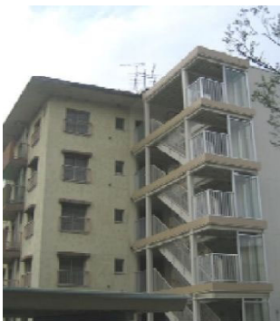
フロア着床型（階段室側）
