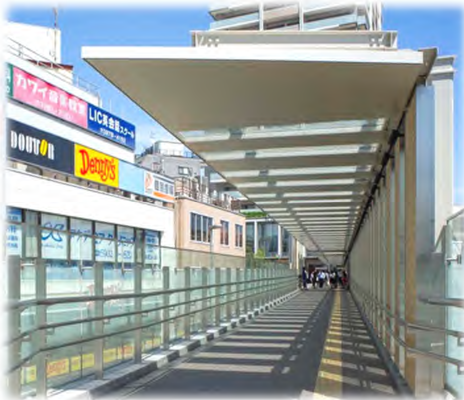
写真：有効幅員3mの通路例2（大泉学園駅北口ペDESTリアンデッキ／練馬区）
