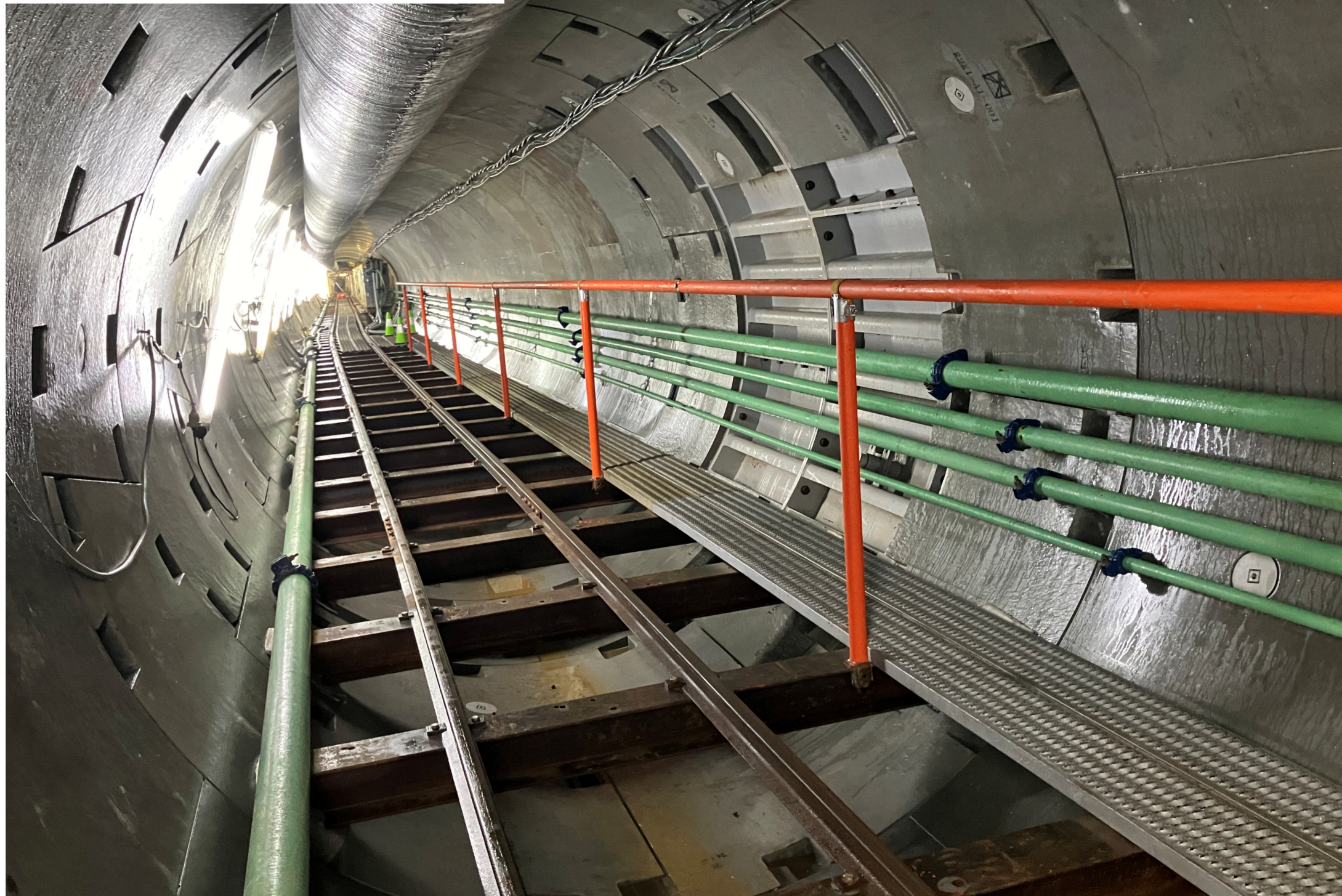
③箇所 管内状況 (2024. 7. 25)
