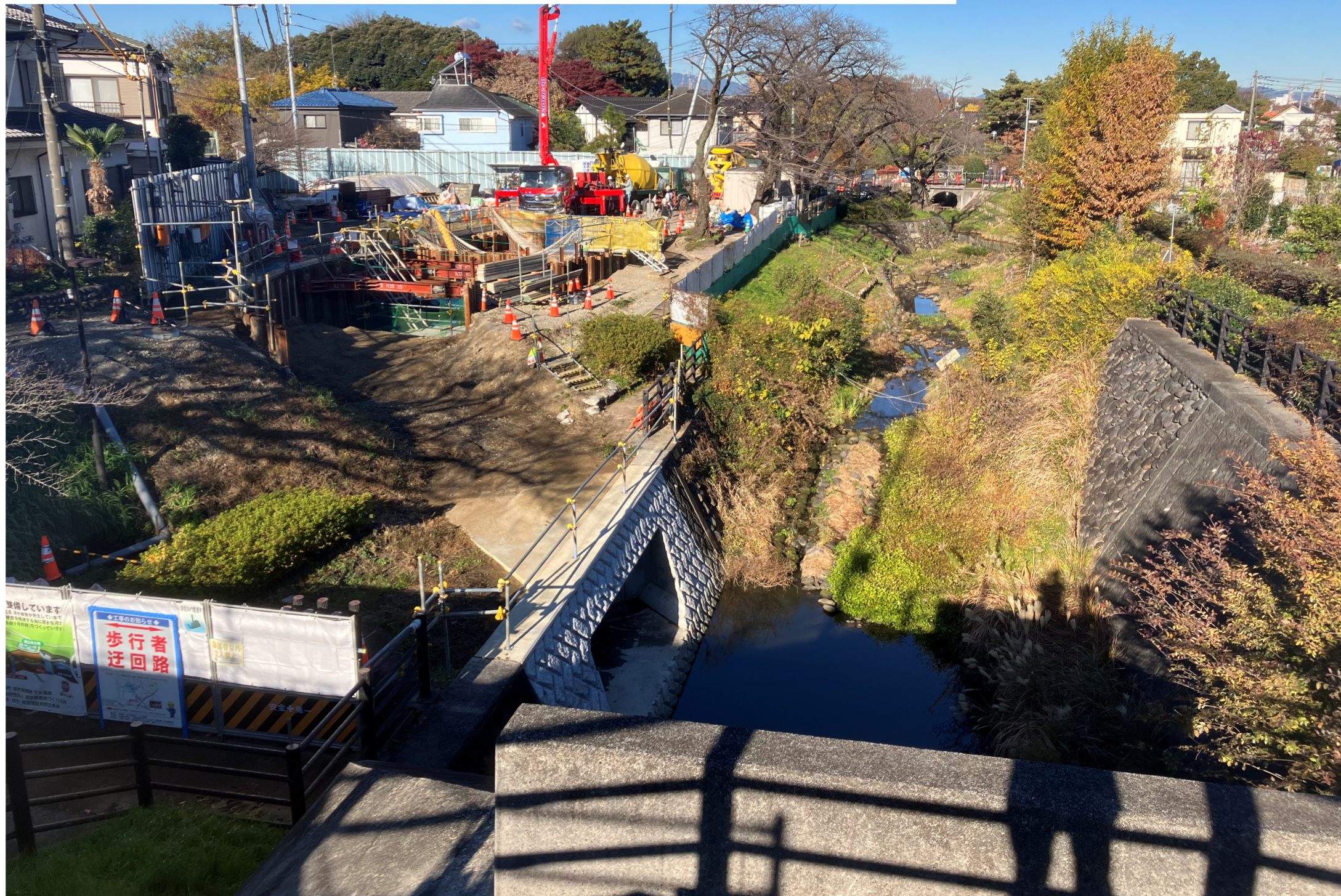
TNo. 2 特殊マンホール コンクリート打設状況 (2024. 12. 5)
