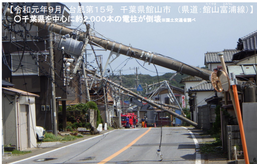
写真 1.1 災害時の救援活動を妨げる電柱
