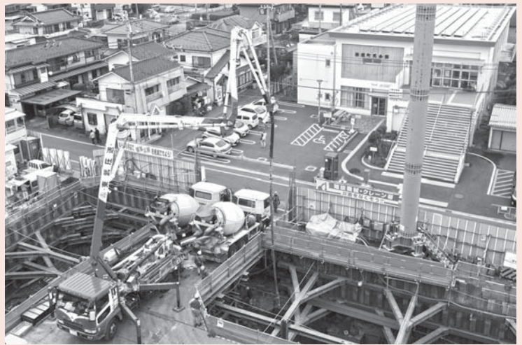
▲町民会館（右上）と進行中の新庁舎建設工事
