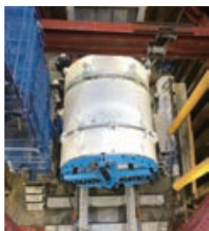
シールドマシン設置状況
