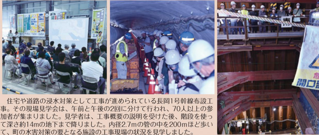
住宅や道路の浸水対策として工が進められている長岡1号幹線布設工事。その現場見学会は、午前と午後の2回に分けて行われ、70人以上の参加者が集まりました。見学者は、工事概要の説明を受けた後、階段を使って深さ約14mの地下まで降りました。内径2.7mの管の中を200mほど歩いて、町の水害対策の要となる施設の工事現場の状況を見学しました。
